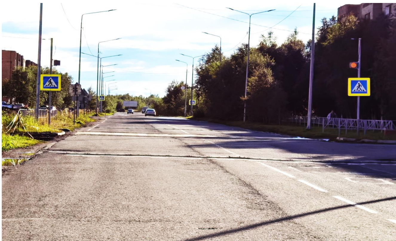
Пешеходный переход по ул. Мира от дома № 47 к дому № 50.
